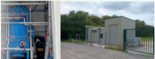
*Filtre à charbon actif en grain (CAG) : matériau hautement poreux retenant les pesticides et métabolites*
