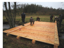
Installation d'une passerelle en bois
