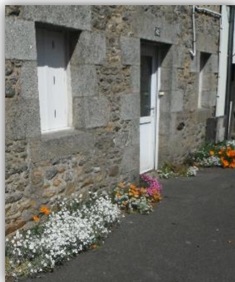
Fleurissement des pieds de mur
