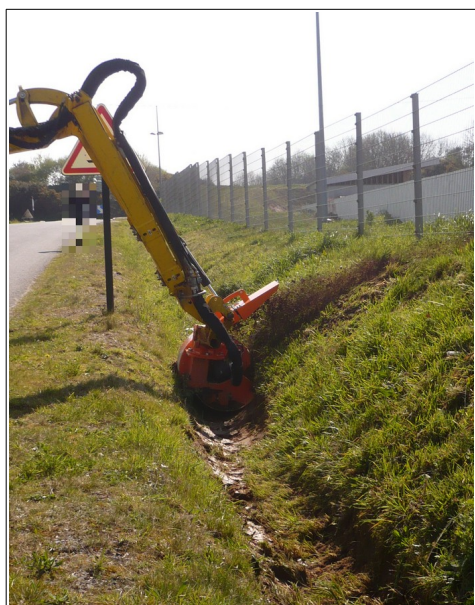
Figure 10. Démonstration de l'utilisation d'une autocureuse – Centre d'Exploitation de Caouennec
