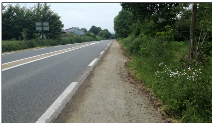
Figure 13. Dérasement dissocié du curage - RD8 - Centre d'Exploitation de Bourbriac
