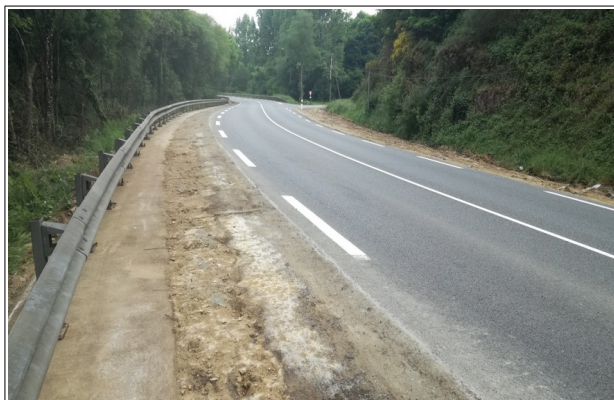
Figure 6. Dérasement d'accotement sur la RD8 – Centre d'Exploitation de Bourbriac
