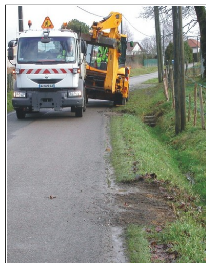
Figure 5. Saignées réalisées au tractopelle
